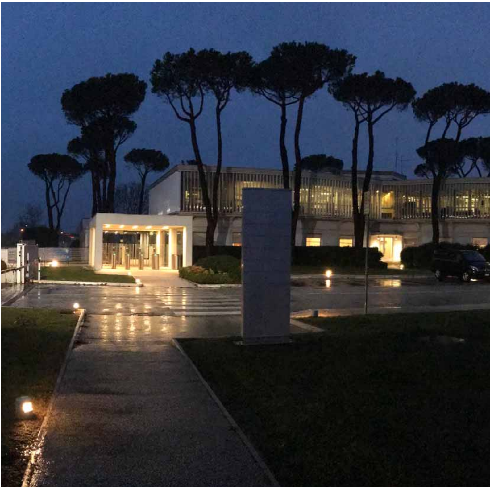
Ingresso sede Gruppo Trevi | Cesena, Italia
