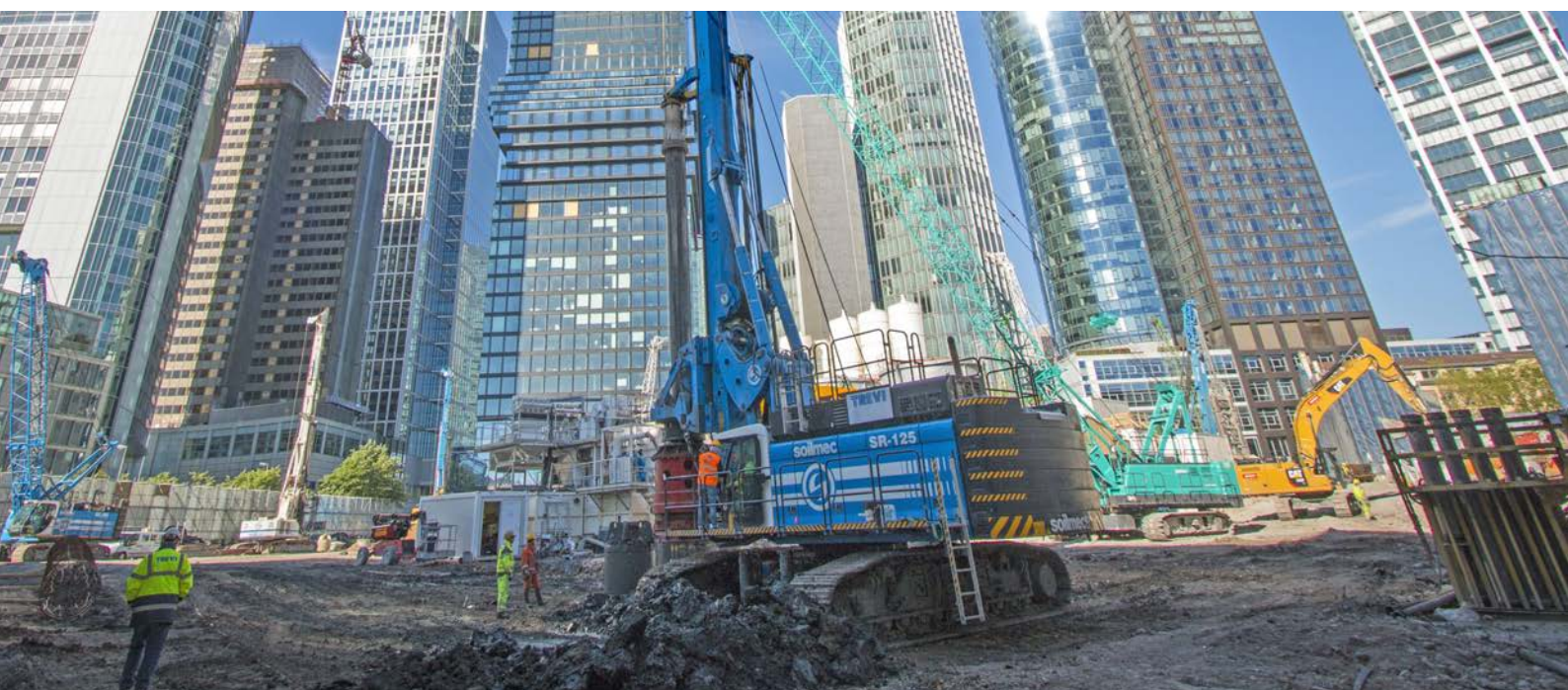
Consolidamenti per il Progetto "4 Frankfurt" - Germania
