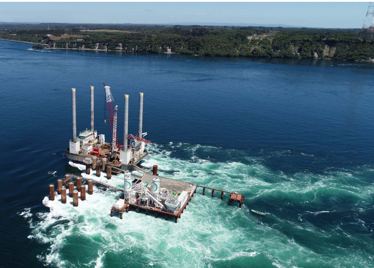
Ponte di Chacao, opere di fondazione per la pila numero 1 - Cile
