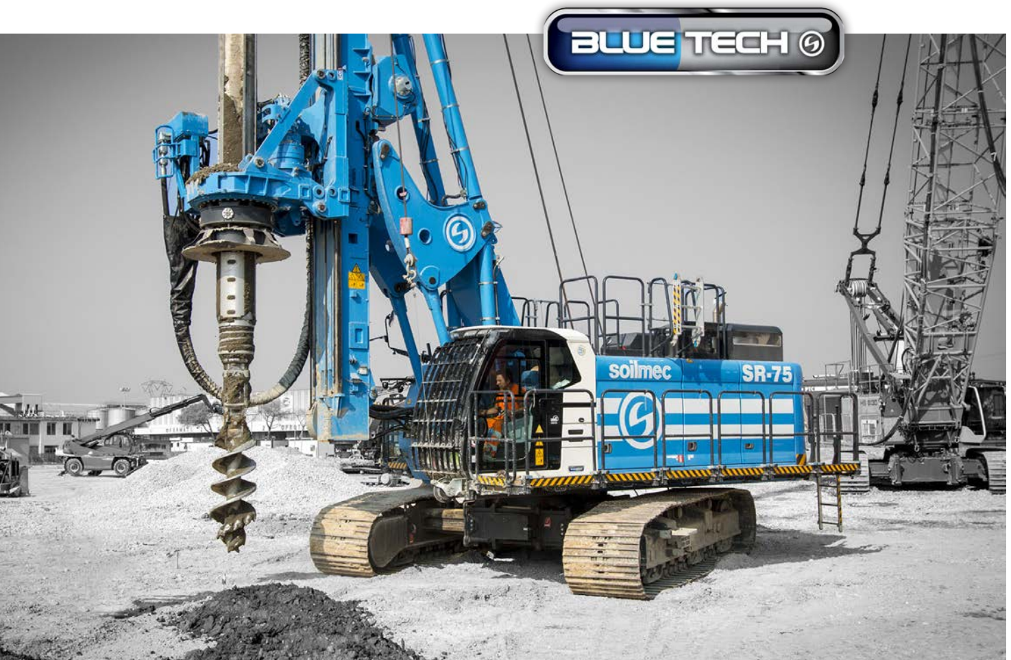
La prima SR-75 Blue Tech Line in cantiere, Ravenna - Italia
