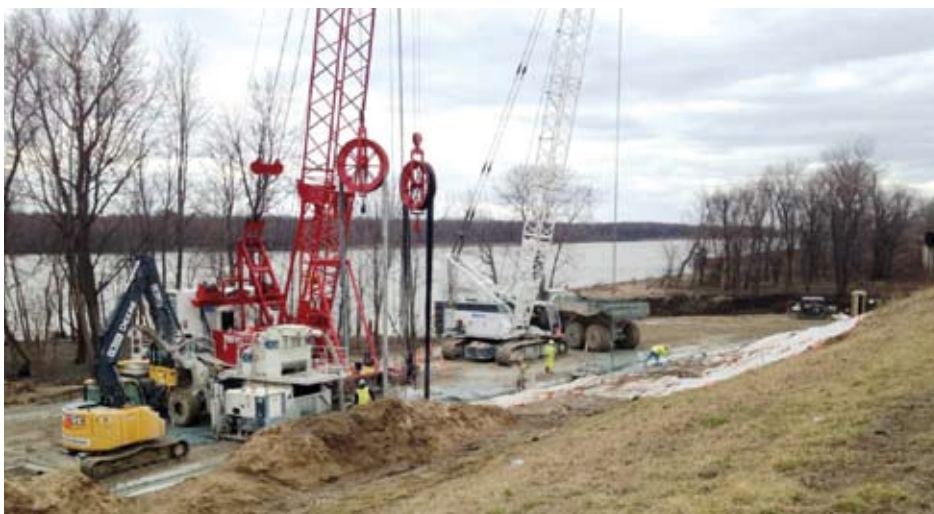
Nelle foto, il "Panel Method" utilizzato per costruire il muro di taglio continuo nei pressi del fiume Mississippi./In the photos, the "Panel Method" used to construct the continuous cutoff wall near Mississippi River.
