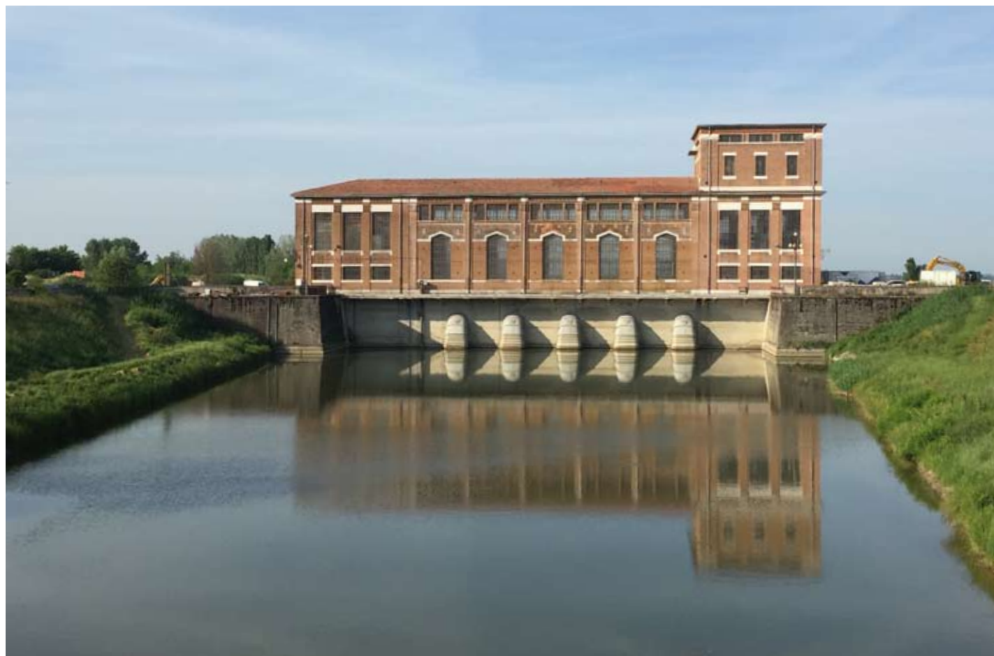
L'impianto idrovoro "Le Mondine", inaugurato nel 1926./The water-scooping plant "Le Mondine", opened in 1926.
