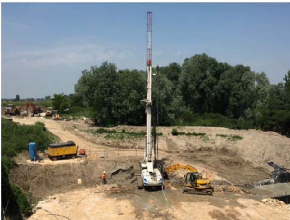
La Soilmec R-312 durante le lavorazioni./Soilmec R-312 during works.
