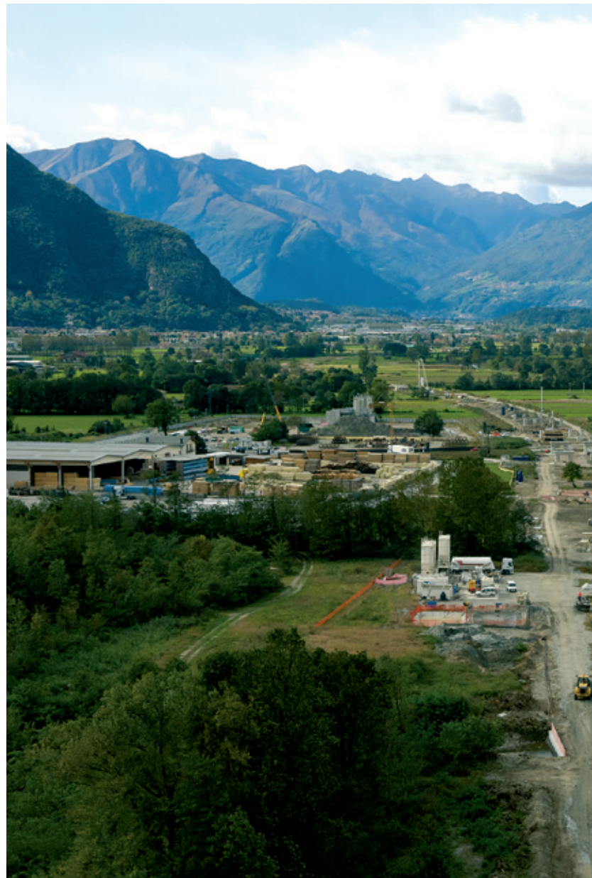
Opere di fondazione per l'autostrada Pedemontana - Italia
