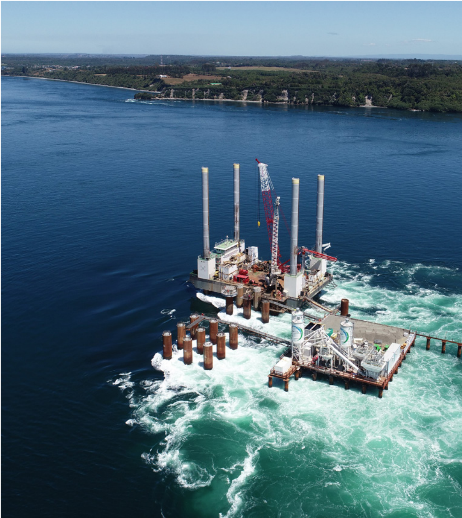
Opere di fondazioni per il Ponte di Chacao, Cile
