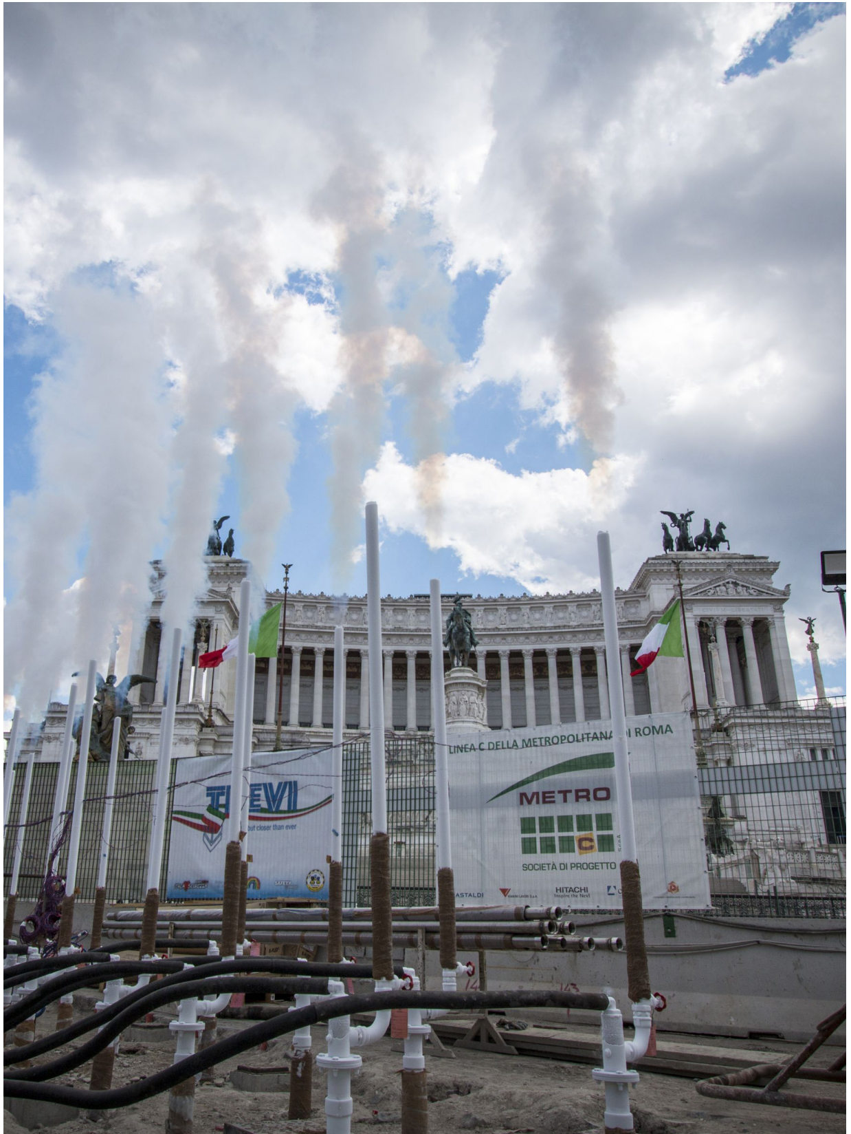
Nella foto: Trevi - Campo prove per la stazione di Piazza Venezia della Linea C della Metro - Roma - Italia
