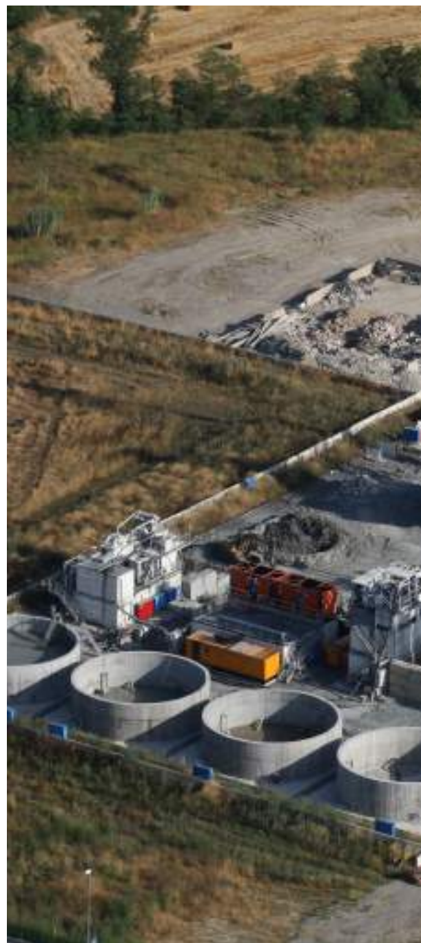
Sistema Soilmec di vibrovaglio detriti di scavo con separazione granulometrica e riutilizzo in cantiere o conferimento in discarica
