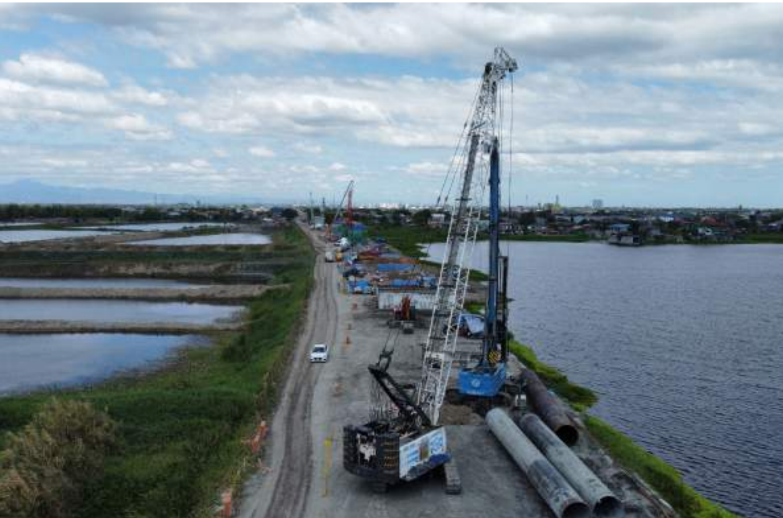
Attrezzature Soilmec per Malolos project | Trevi Philippines, Regione del Luzon, Filippine
