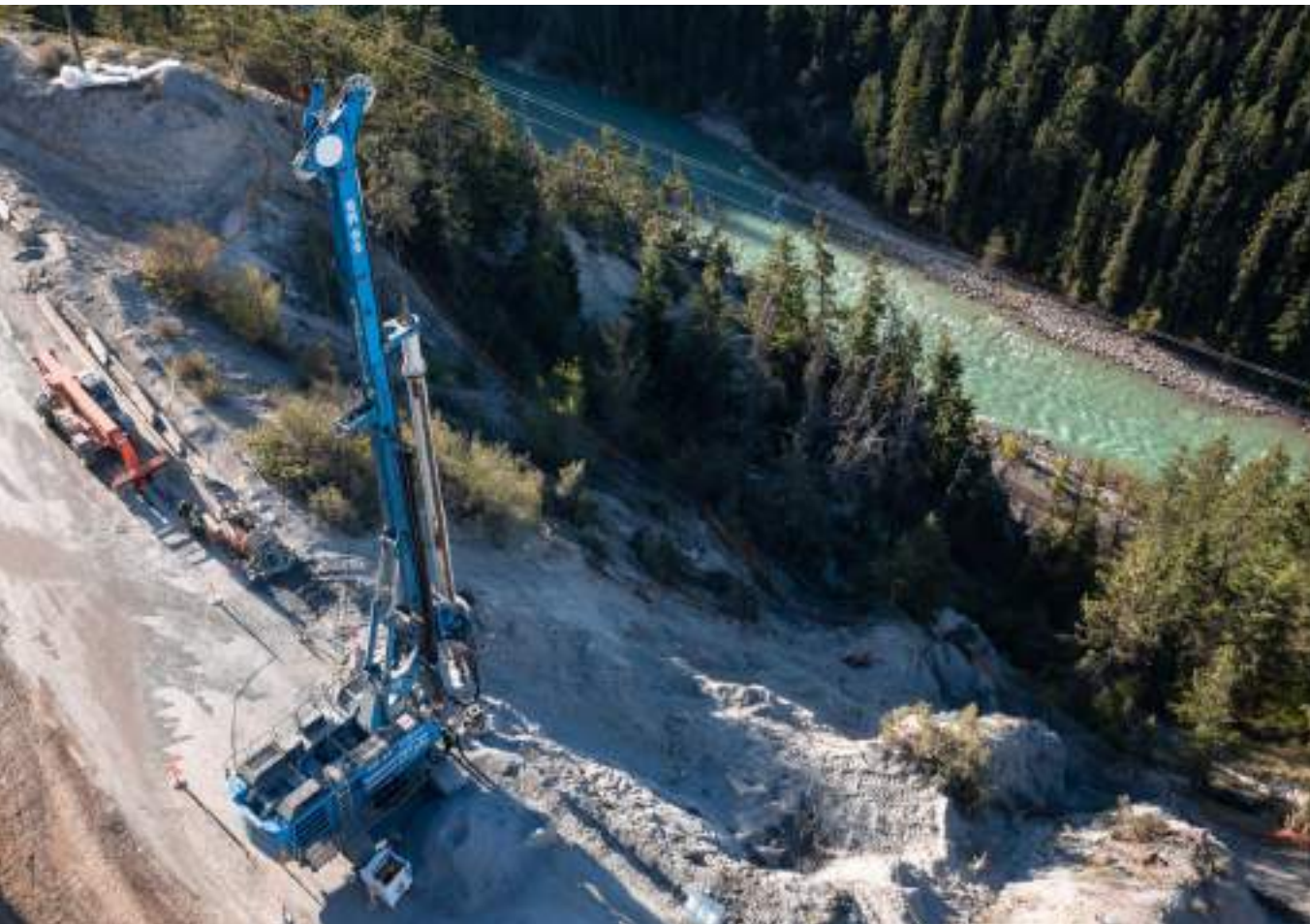
Attrezzatura Soilmec della linea Bluetech, in cantiere.
