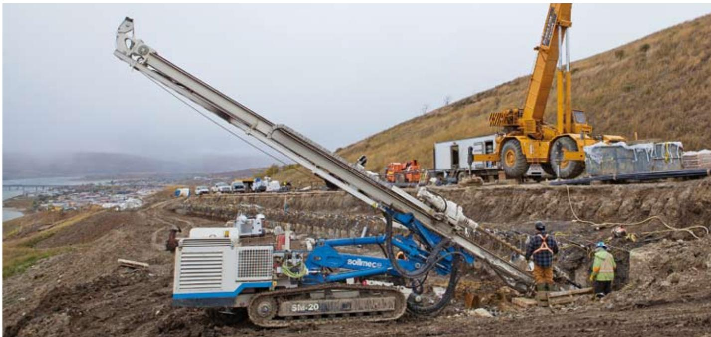
La Doublestar Drilling ha acquistato attrezzature Soilmec SM-14 e SM-20 per la micro perforazione e l'ancoraggio appositamente per questo lavoro a Peace River (Per gentile concessione di Doublestar Drilling).
