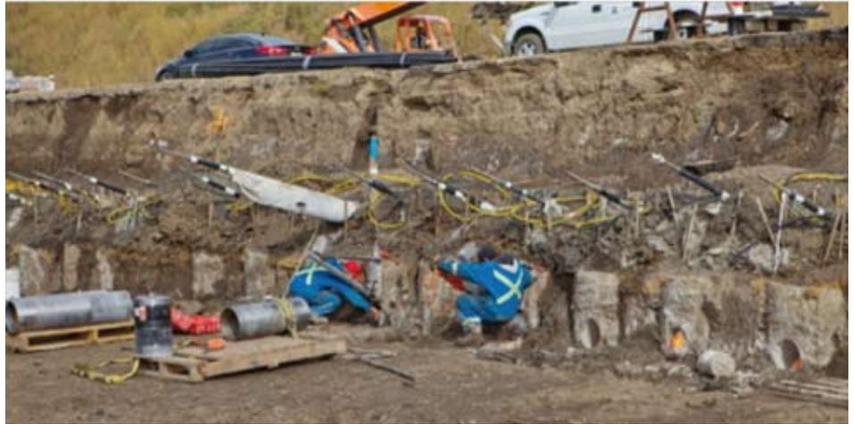
Due file di ancoraggi sono stati installati nel primo muro di pali tangenti a inclinazione 25 gradi (fila superiore) e 30 gradi (fila inferiore) sull'orizzontale, distanziate di 0,5 m ciascuna (Per gentile concessione di Doublestar Drilling).
