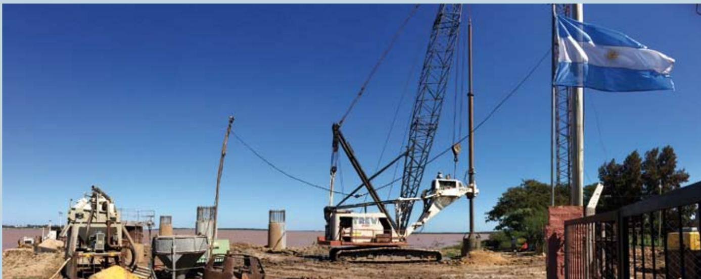
Pilotes Trevi sta eseguendo dei pali per l'opera di presa di un acquedotto a Resistencia, Stato di Chaco in Argentina.
