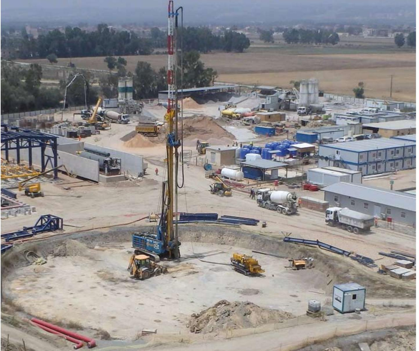
Una Soilmec SR 75 del nostro cliente Keller in azione per "displacement piles" alla profondità di 30,5 m .
