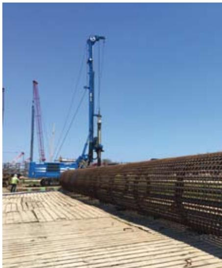
USA/**Soilmec SR-45** del cliente texano Wylie Drilling che perfora un pozzo da 9'x101'.
