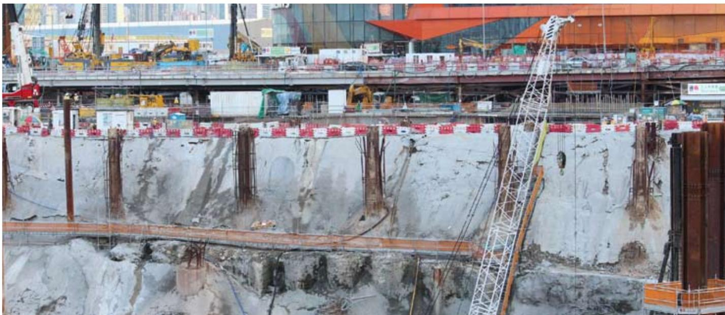
Vista del cantiere per il nuovo West Kowloon Terminus: in basso nella foto, le colonne di jet grouting.
