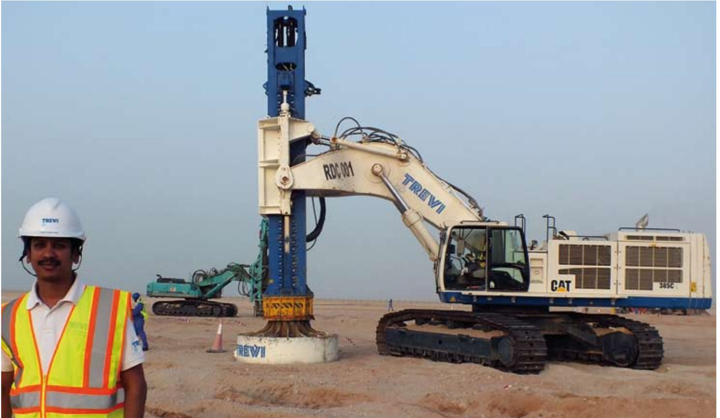
Swissboring si è aggiudicata un nuovo lavoro a Ruwais per 1.000.000 di m<sup>2</sup> di Compattazione Dinamica Rapida (RDC) da completare in 2 mesi. Al Ruwais è situata circa 240 chilometri a ovest da Abu Dhabi. La macchina speciale utilizzata da Swissboring sta fornendo una produzione tre volte superiore a quella del nostro concorrente sul posto, come confermato dal nostro cliente.
