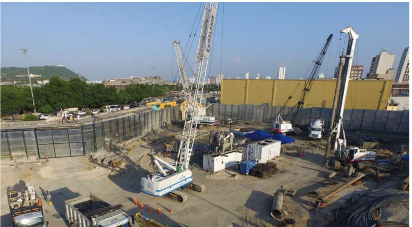
Macchine Soilmec al lavoro per le fondazioni del nuovo complesso./Soilmec drilling rigs at works for the foundation works of the new building.
