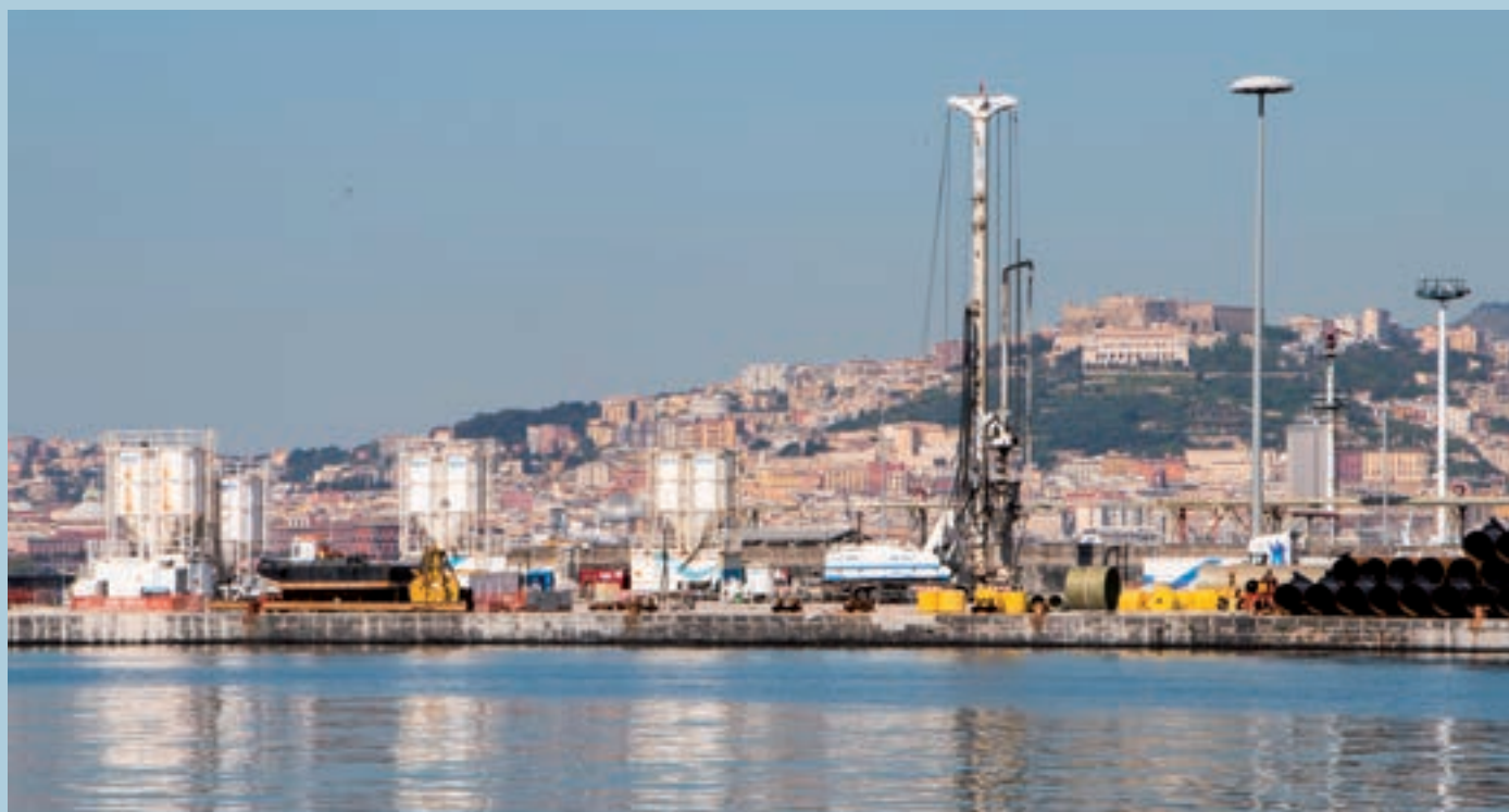
Soilmec SR-100 in azione per pali in CSP nell'ambito dei lavori di adeguamento a terminal container della darsena di Levante del Porto di Napoli. A Soilmec SR-100 in action for CSP piles during the adaptation work to container terminal of the Levante dock in the Port of Naples.
