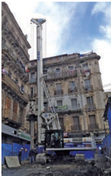
Soilmec SR-60 al lavoro nel centro di Algeri.
