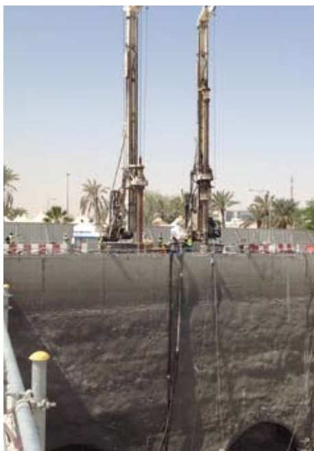
Stazione Al Bidda – Red Line North – Consorzio ISG (Impregilo SK Galfar): pali trivellati diametro 1.000 mm per sistema di "dewatering".
