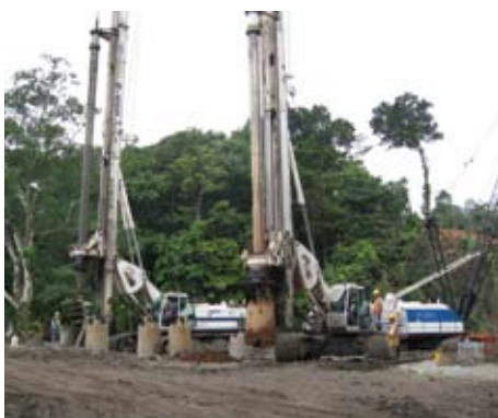
Macchine Soilmec in azione a Panama. Soilmec machines in action in Panama.
