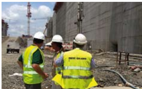
Trevi Galante al lavoro lato Pacifico. Trevi Galante at work on Pacific Side.
