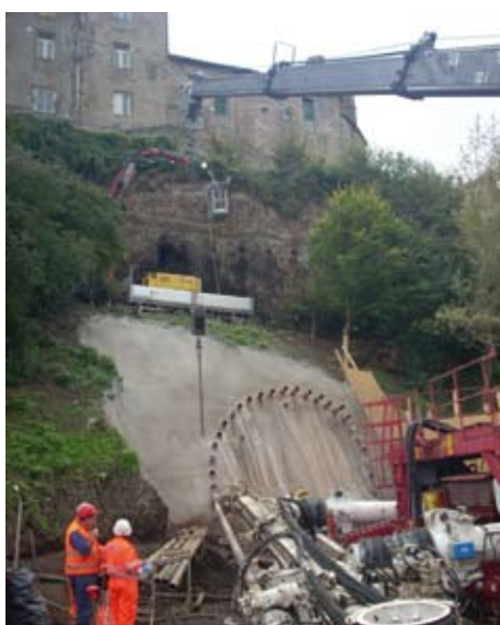
Il fronte di scavo di una delle gallerie di accesso. The excavation front of one of the new access tunnels.
