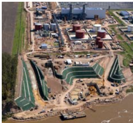
Vista aerea del cantiere della nuova centrale termoelettrica.
