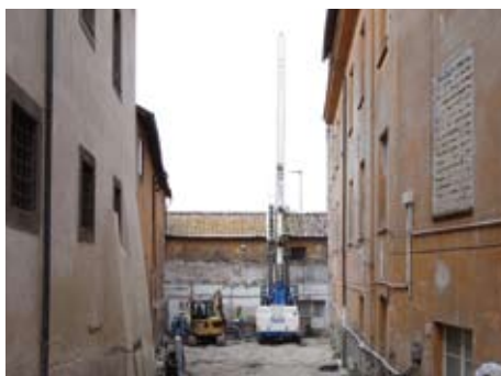
Il cantiere Trevi nel centro storico di Viterbo. The Trevi yard in the historic center of Viterbo.
