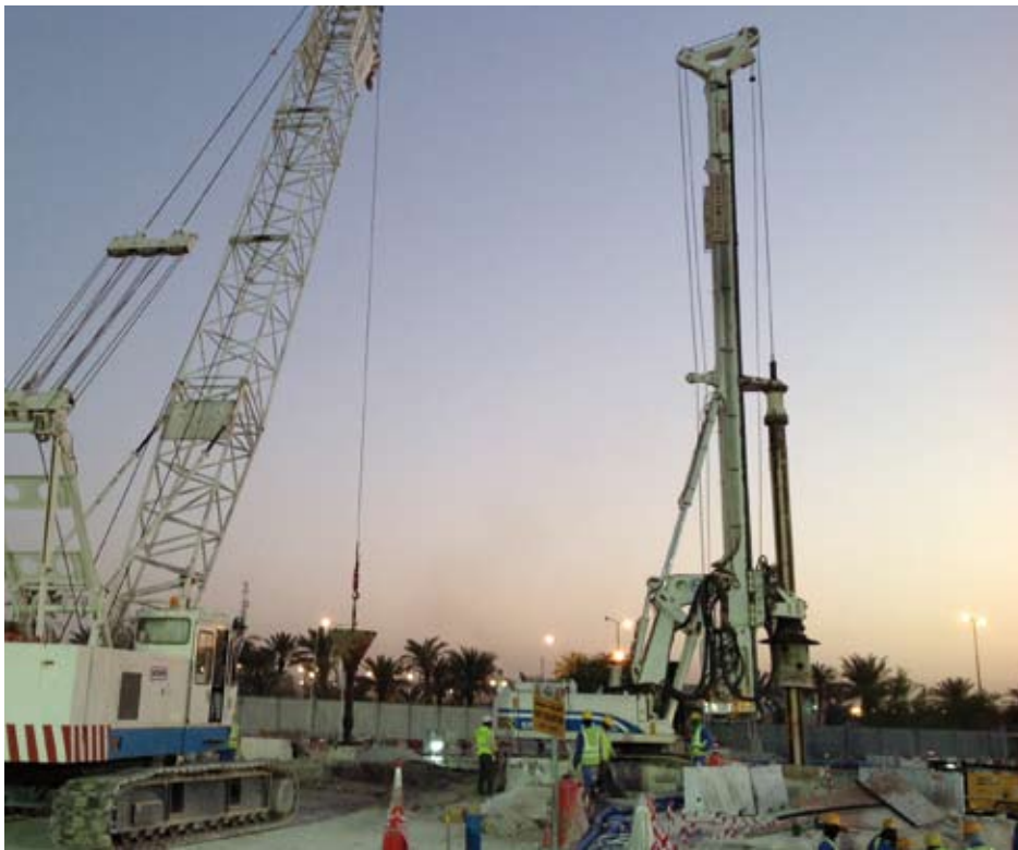
Stazione Al Bidda – Red Line North – Consorzio ISG (Impregilo SK Galfar): realizzazione di pali trivellati diametro 1.000 mm per opere di contenimento.
