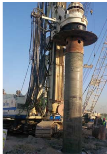
Stazione Cultural Village – Red Line North – Consorzio ISG (Impregilo SK Galfar): esecuzione di pali trivellati diametro 1.000 mm.
