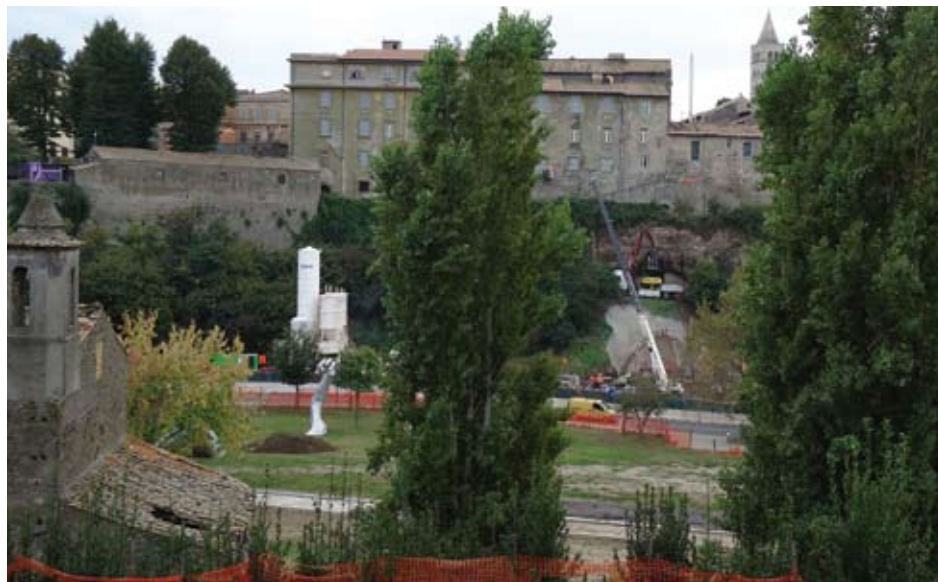
L'area di cantiere per la realizzazione del nuovo collegamento verticale nel centro storico di Viterbo. The construction site for the new vertical connection in the old town centre of Viterbo.
