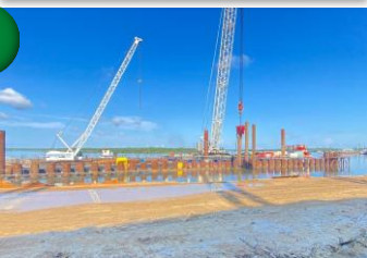
Bua Berth 1 & 2 Port Harcourt (Nigeria)
