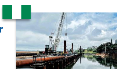
Bua Berth 1 & 2 Port Harcourt (Nigeria)
